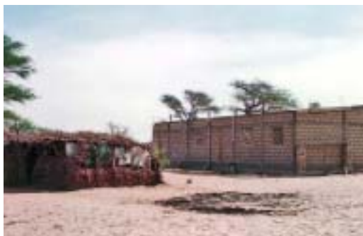
La nova escola en procés de construcció. La nueva escuela en proceso de construcción.
