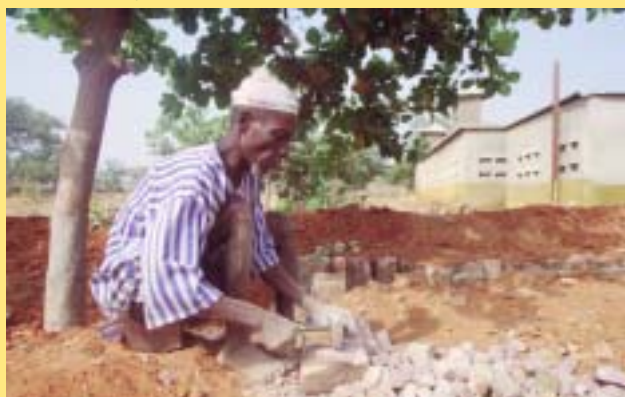
Un obrer treballa picant pedres per a l'ampliació del centre hospitalari. Un obrero trabaja picando piedras para la ampliación del centro hospitalario.
